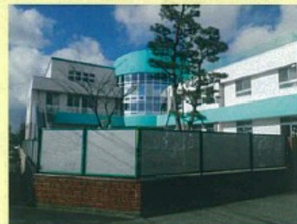
フェンス工事
