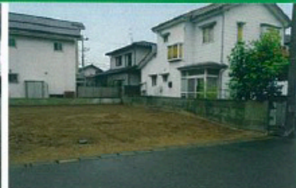
宅地除草工事
